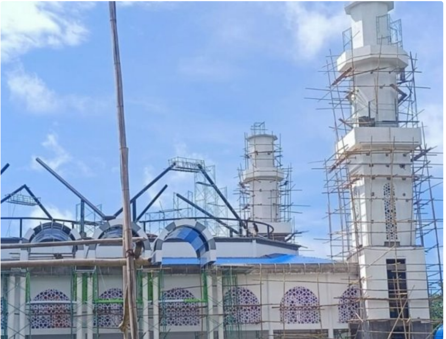
Pembangunan Masjid Agung Al Barru saat ini masih dalam tahap perampungan
